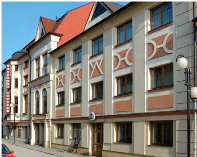
Obrázek 45 Kulturní centrum Česká Třebová. zdroj: (Česká Třebová, 2025)
