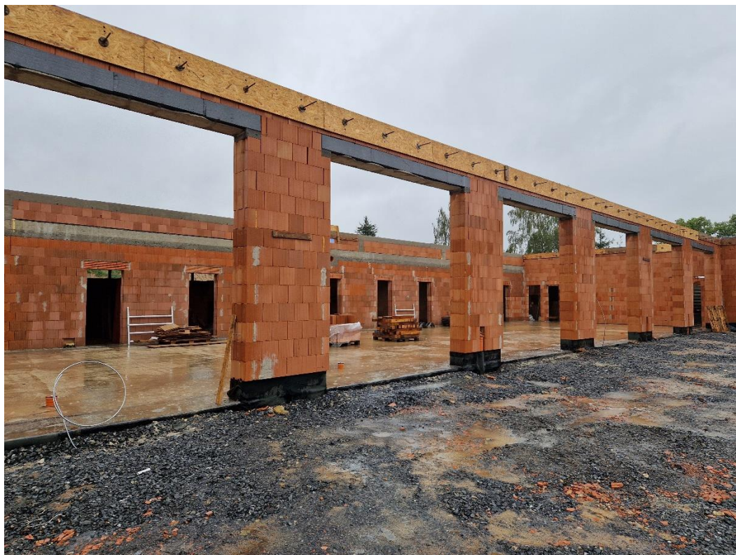
Obrázek 4: Realizace projektu Výstavba nové výjezdové základny ZZS PAK ve Svitavách
