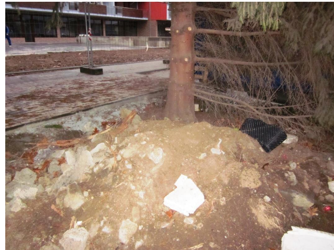
Zasypání kmenů stromů stavebním materiálem nebo odkopyky zeminy
