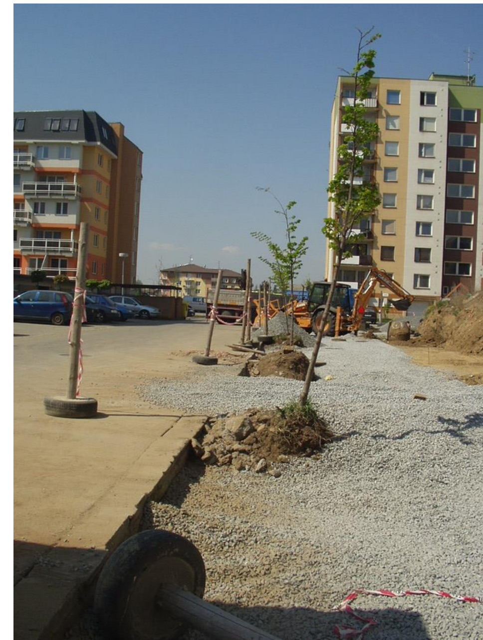
Výsadba stromů stavební firmou v letním období do nepřipravených výsadbových ploch
