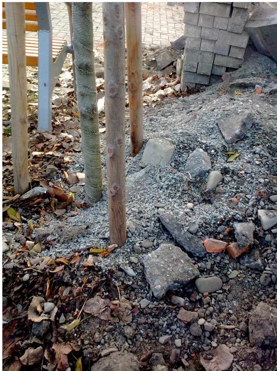
Zasypání kmenů stromů stavebním materiálem nebo odkopyky zeminy
