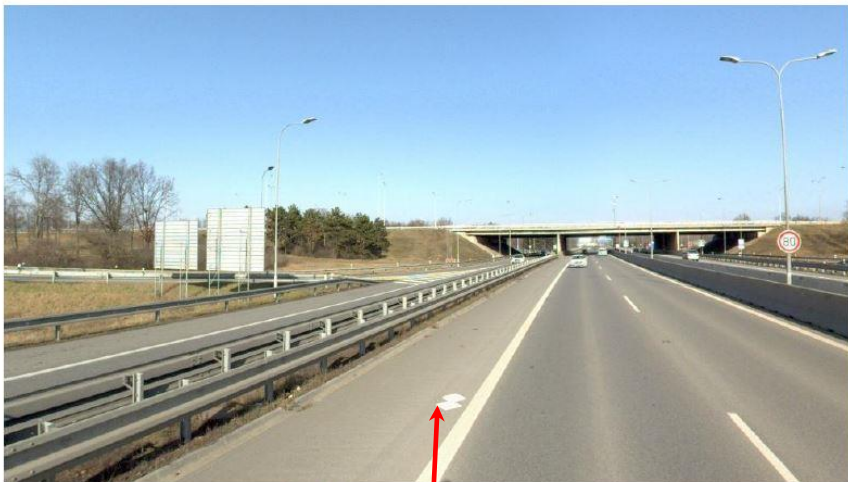
Ukázka provedené signalizace VLB na vozovce
