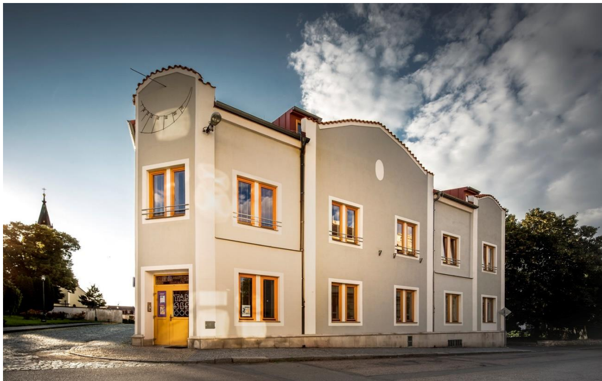
Obrázek 4: IROP – Projekt Transformace Domova Na cestě žadatele Pardubický kraj (foto Tomáš Kubelka)
